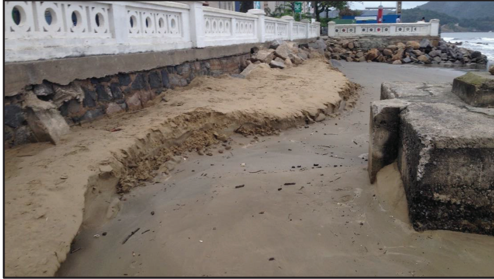
Figura 5-49. Erosão acentuada na ponta da praia, decorrente de incidência de ondas e chuvas, que retiram a areia depositada artificialmente para conter a erosão.
