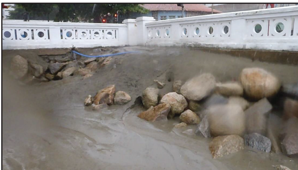
Figura 5-52. Evento de alta pluviosidade removendo sedimentos depositados artificialmente para conter o processo erosivo na Ponta da Praia.
