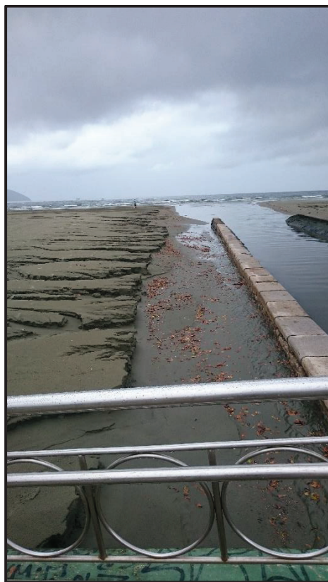
Figura 5-47. Evento erosivo decorrente de escoamento pluvial na lateral dos canais.
