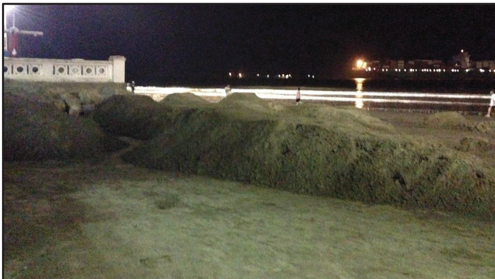
Figura 5-51. Pilhas de areia aguardando para serem espalhadas sobre a face praial na região da Ponta da Praia, a fim de repor as perdas ocasionadas pelos processos erosivos.
