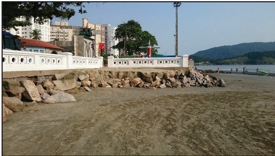
Figura 5-50. Obras de contenção na ponta da praia, com presença de enrocamento e areia depositados artificialmente.
