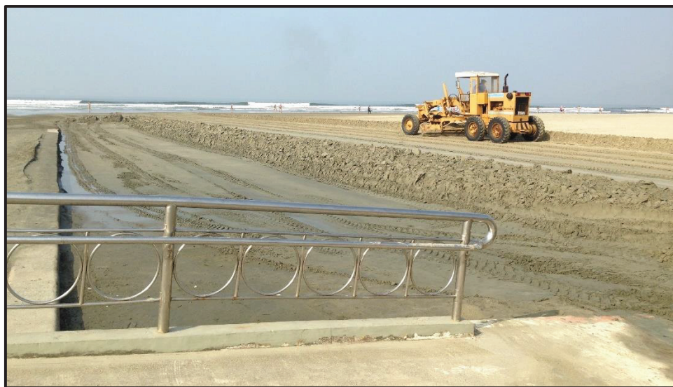
Figura 5-48. Maquinas realizando retificação no perfil praiado adjacente ao canal, antes erodido por escoamento pluvial.
