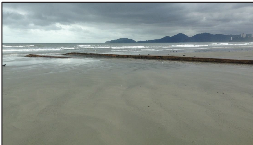
Figura 5-46. Paredes do canal interferindo no transporte sedimentar ao longo do arco praiial de Santos.
