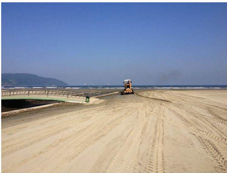
**Figura 213** – Trator remobilizando areia da praia para desassoreamento do canal 2.
