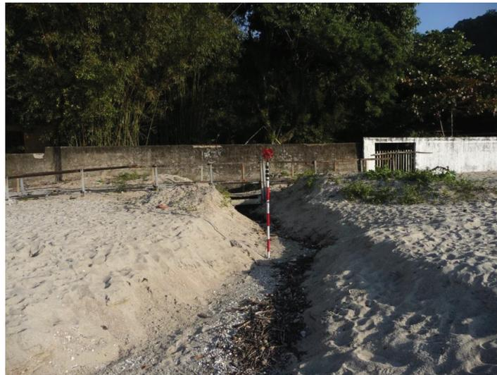
**Figura 211** – Canal escavado para escoamento de água através da faixa de areia da Praia do Góes (G-4).
