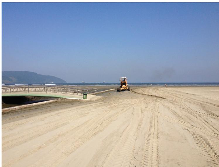
**Figura 183** – Trator remobilizando areia da praia para desassoreamento do canal 2.
