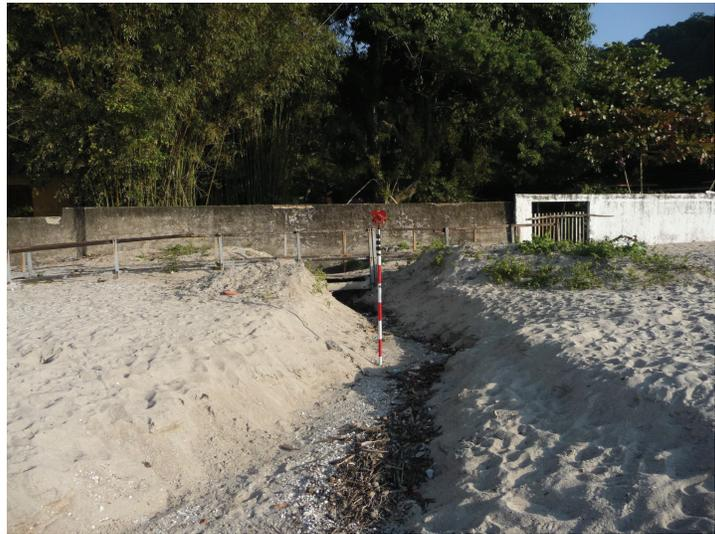
**Figura 181** – Canal escavado para escoamento de água através da faixa de areia da Praia do Góes (G-4).
