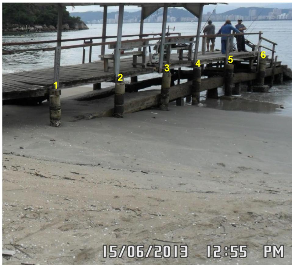
Figura 8.3.1.1.1-4. Redução do nível de areia na base do píer da Praia do Góes entre dezembro de 2011 (acima) e junho de 2013 (abaixo). Ambas as imagens foram obtidas em situação de maré de quadratura, em fase de subida da maré e tempo bom.
