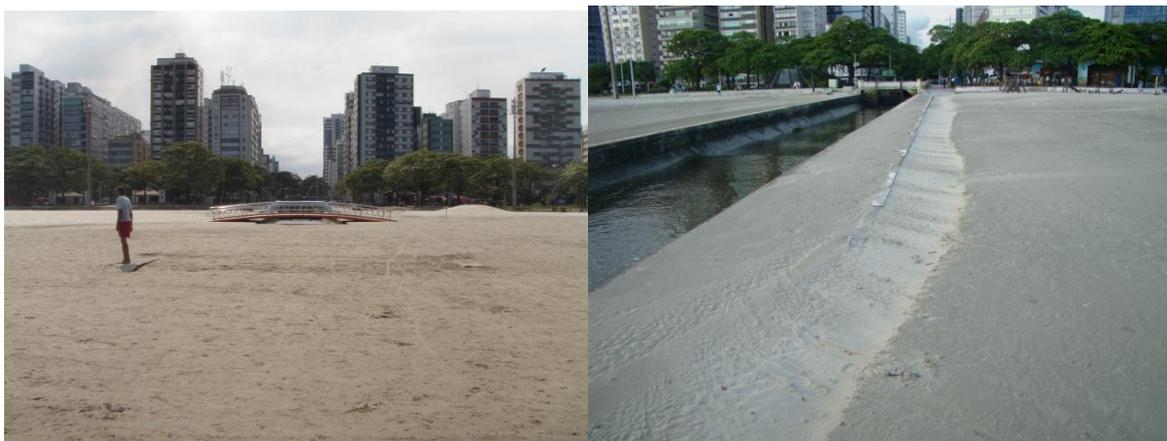
Figura 8.3.3.5-1. À esquerda, intenso assoreamento do Canal 2 em decorrência das ressacas do início de 2010, em especial a de 08 de abril (imagem de 05 de maio de 2010). À direita, evidências de transporte eólico promovendo o cavalgamento das areias sobre a mureta do Canal 3 e o consequente transporte para o seu interior (imagem de 24 de fevereiro de 2011).
