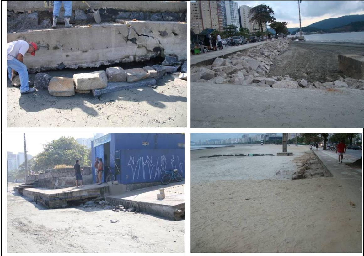
Figura 8.3.2.3-2. Intensificação da erosão praial e comprometimento de estruturas urbanas devido à ressaca de 03/maio/2011 nas áreas do perfil Stos-23 e arredores (acima e abaixo à esquerda) e do perfil Stos-22 (abaixo à direita), onde houve exposição do antigo aterro na pós-praia.
