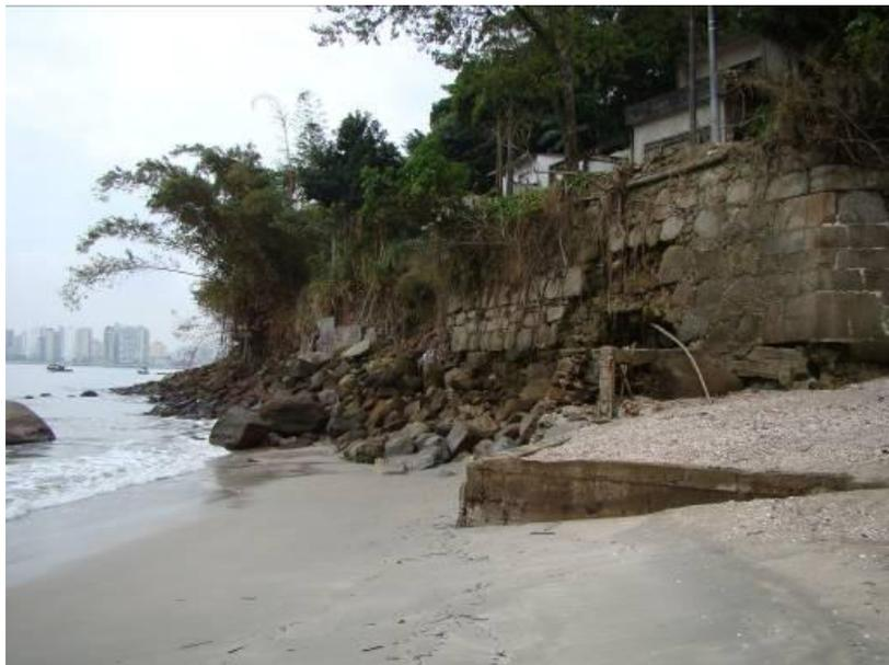
Figura 8.3.2.1-9. Erosão intensa na vertente da Ponta dos Limões, a leste da Praia do Góes: à esquerda, trilha que liga essa praia à da Pouca Farinha seriamente comprometida e casa em risco de desabamento; à direita, erosão intensa nas paredes do antigo Fortim (sítio histórico). Notar a grande acumulação de areia e conchas na estrutura em pedra sobre a praia, resultado da ressaca de 03/maio. (fotos de 22/05/2011).
