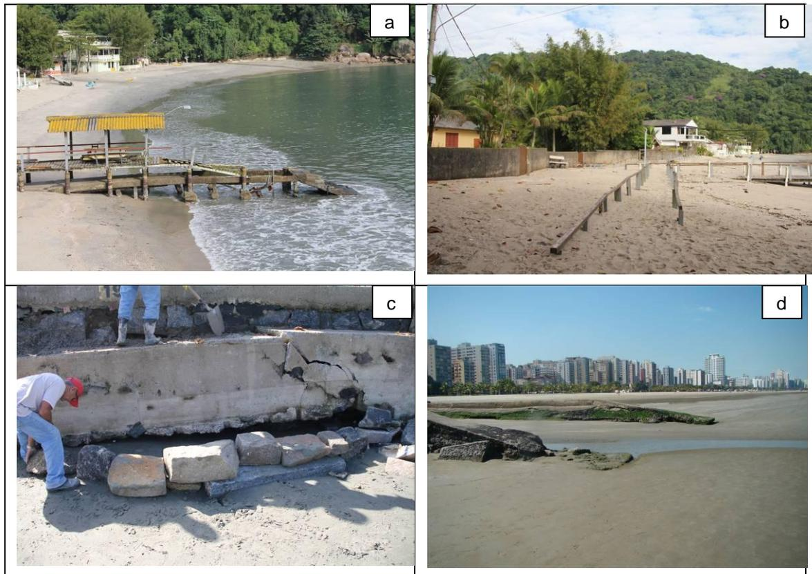
Figura 8.3.2-3. Consequências da ressaca de 03/05/2011 (fotos obtidas no dia 04/05). Acima, na Praia do Góes: (a) terminação do píer bastante erodida, e (b) forte empilhamento sedimentar, com as areias recobrendo toda a ponte de acesso ao píer. Abaixo em Santos: (c) Ponta da Praia, em frente ao perfil Stos-23 (alinhamento com a marca amarela “19” na parte superior da foto), nas obras de recuperação do muro e da calçada, que solaparam com a ressaca; (d) assoreamento intenso no Canal 1.
