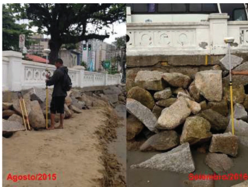
Figura 2-81. Forte processo erosivo junto ao perfil STOS23, com rebaixamento do pós praia e da face praial, estreitamento da faixa de areia e pós praia praticamente inexistente. Na foto estão apresentadas as condições em Agosto de 2015 e Setembro de 2016.
