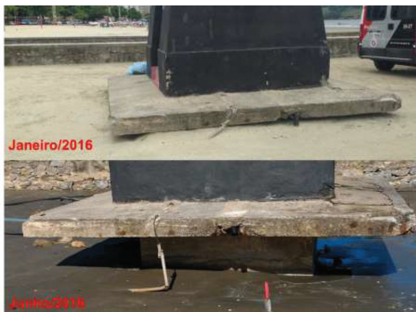
Figura 2-79. Forte processo erosivo na base do farol junto ao perfil STOS20. Na foto estão apresentadas as condições em Janeiro de 2016 e Junho de 2016.
